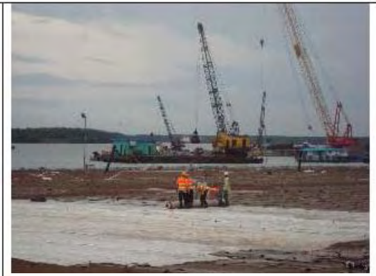
Hình 18: Rải vải địa kỹ thuật
