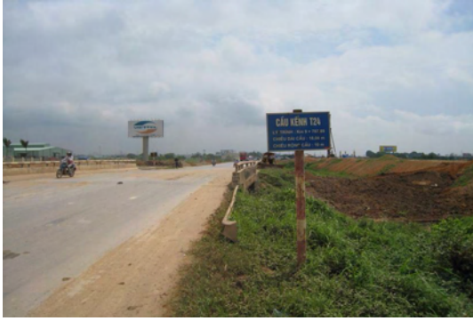
Hình 1. Cầu kênh T24, Dự án Láng – Hòa lạc
