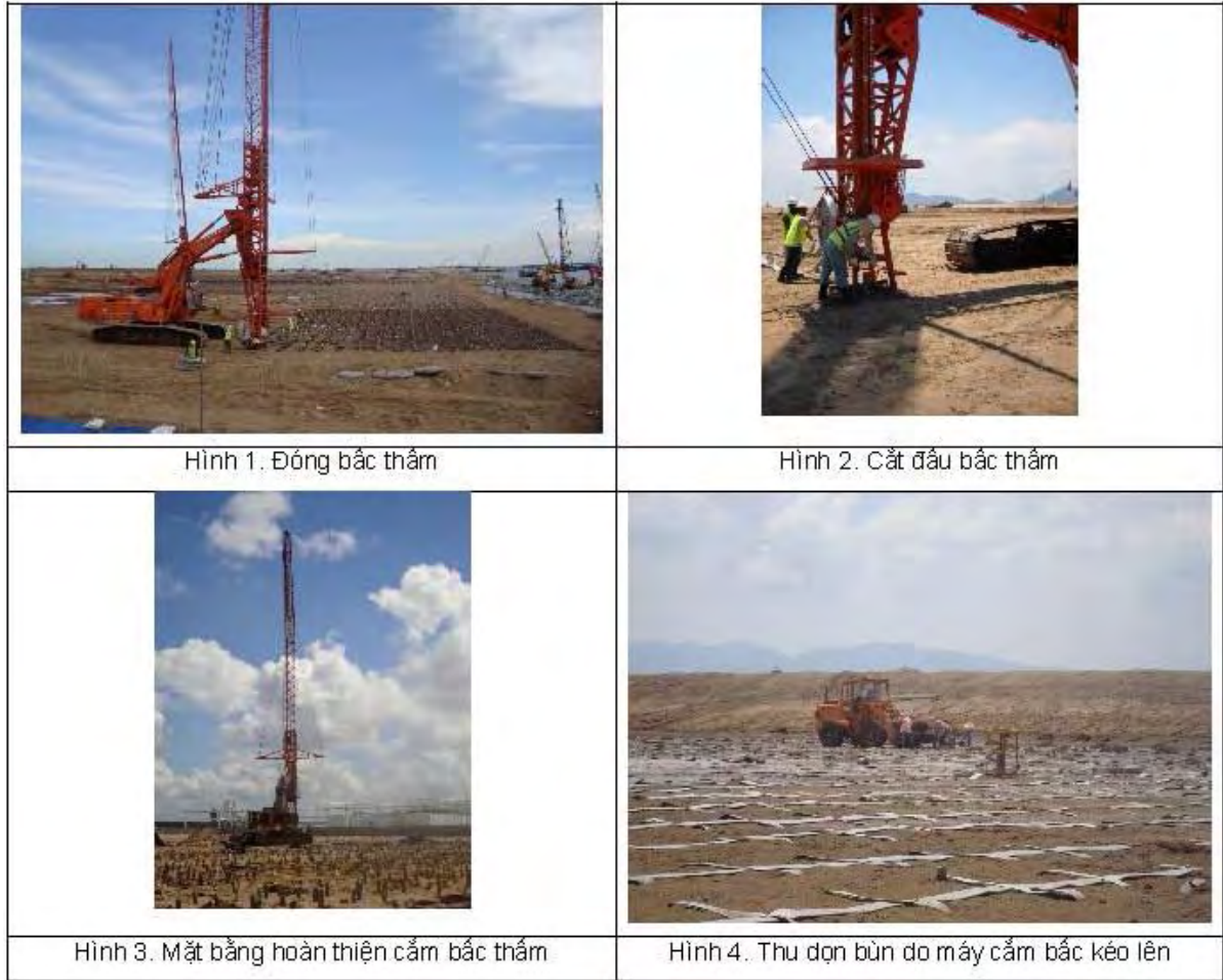
Hình 12: Hình ảnh hiện trường thi công PVD
